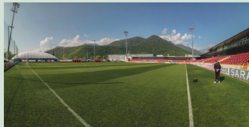
QƏBƏLƏ ŞƏHƏR STADIONU
